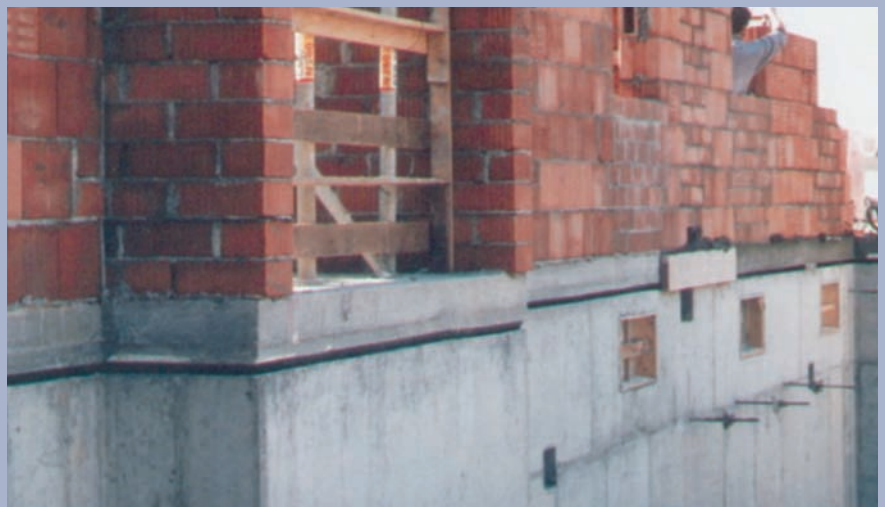
Bild 2: Ausgeschaltete fertige Lagerfuge
