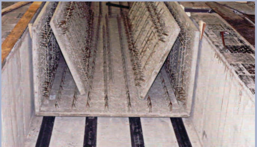
Bild 2: Seitliche Fixierung der Filigranplatten im Einbauzustand
